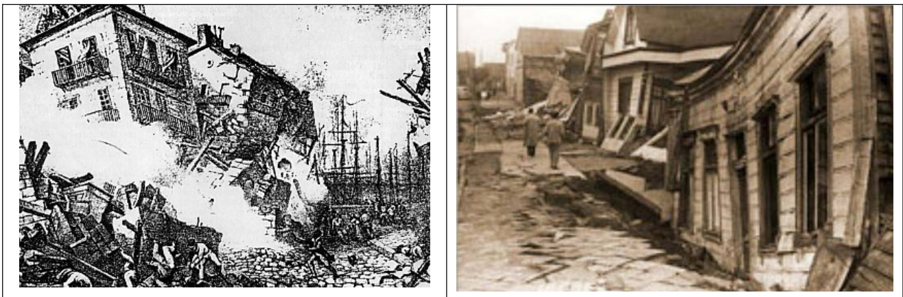
Figure 14 Images des destructions liées au séisme de 1843 et de l'incendie qui s'est déclaré peu de temps après le séisme à Pointe-à-Pitre (Guadeloupe)
